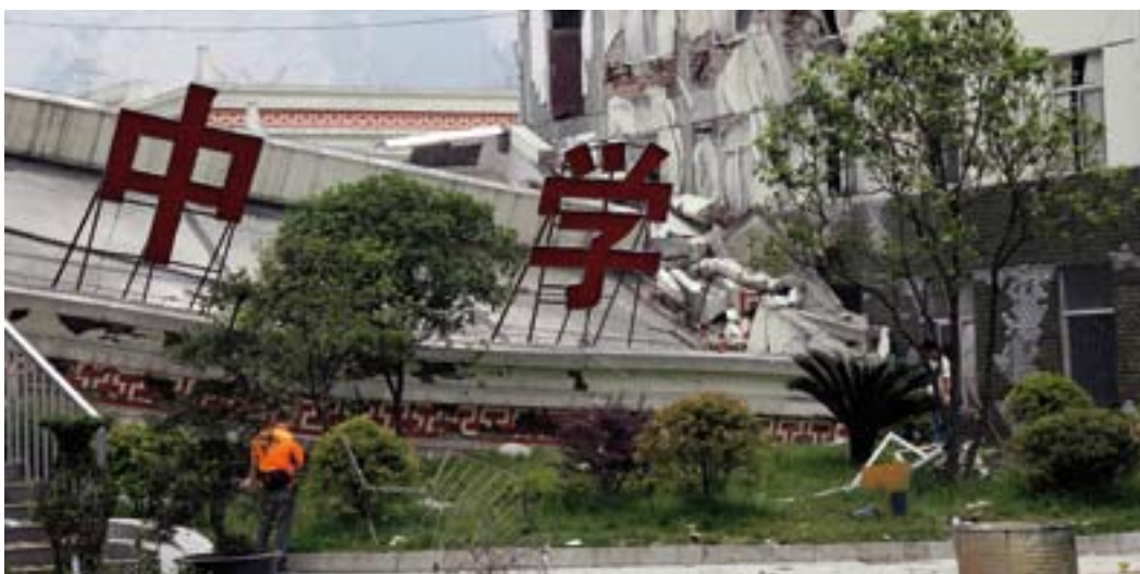
En el municipio de Ying Xiu, China, varios niños quedaron atrapados al derrumbarse esta escuela de enseñanza media durante el terremoto de Wenchuan del 12 de mayo. Según estimaciones, cuatro mil de los diez mil residentes del municipio murieron allí, en el epicentro del terremoto.
