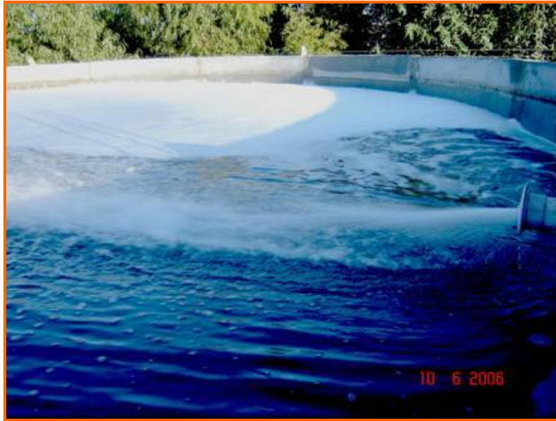
Figura 4. Tratamiento el agua residual en un reactor biológico. UNRC. Río Cuarto. Córdoba
