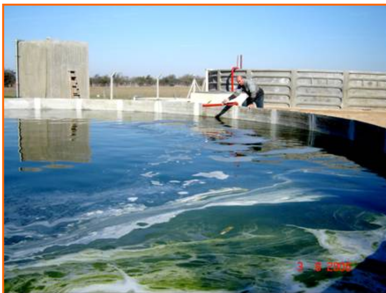
Figura 5. Laguna de maduración. UNRC. Río Cuarto. Córdoba
